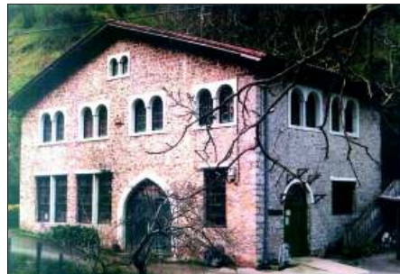
Edificio del actual Centro. Barrio Artzabal. Deba 2006. Archivo del Centro.
